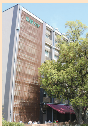
武蔵大学11号館建設
